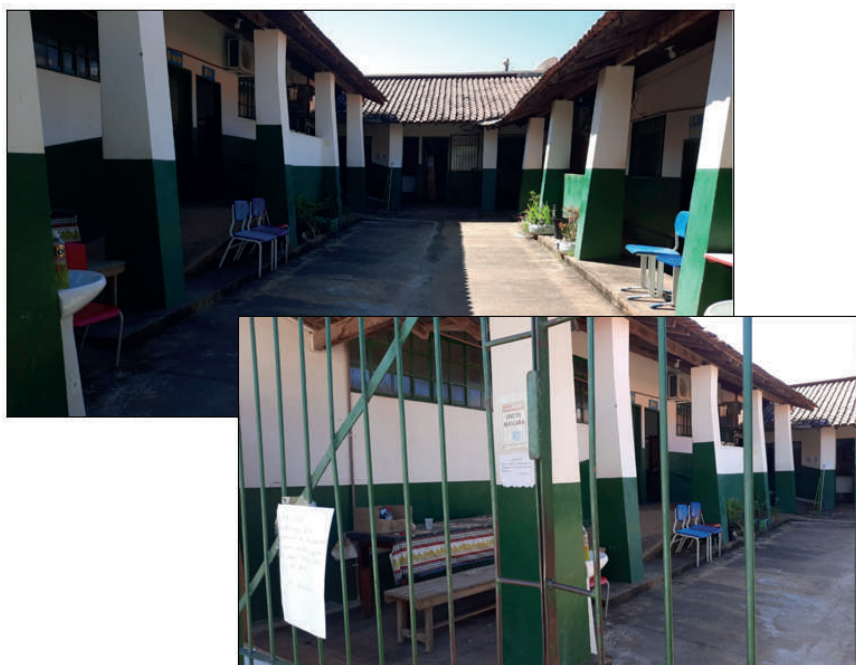
Figura 4 - Vista do pátio e portão fechado da escola Profa. Felipa Serrão Botelho.
