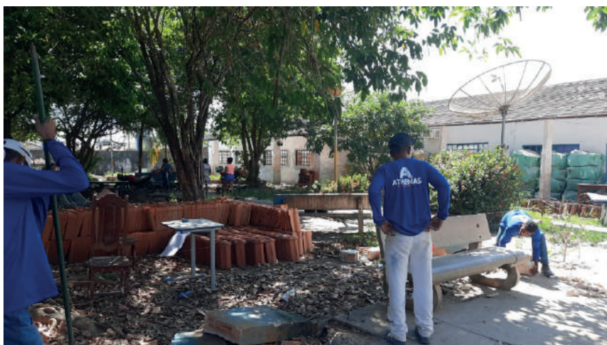
Figura 2 - Trabalhadores atuando na reforma da escola Salomé Carvalho.
