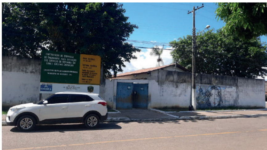
Figura 1 - Vista da fachada da escola Salomé Carvalho.
